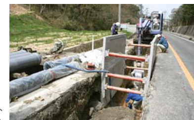
下水道整備 公共用水域の水質を保全し、快適な生活環境を確保します。
