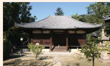
国指定重要文化財 本蓮寺 本堂
